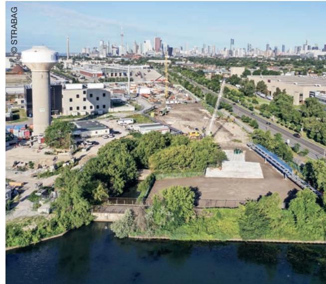
Auf diesem Areal der Ashbridges Bay Wasseraufbereitungsanlage in Toronto wird das Pumpwerk entstehen.
