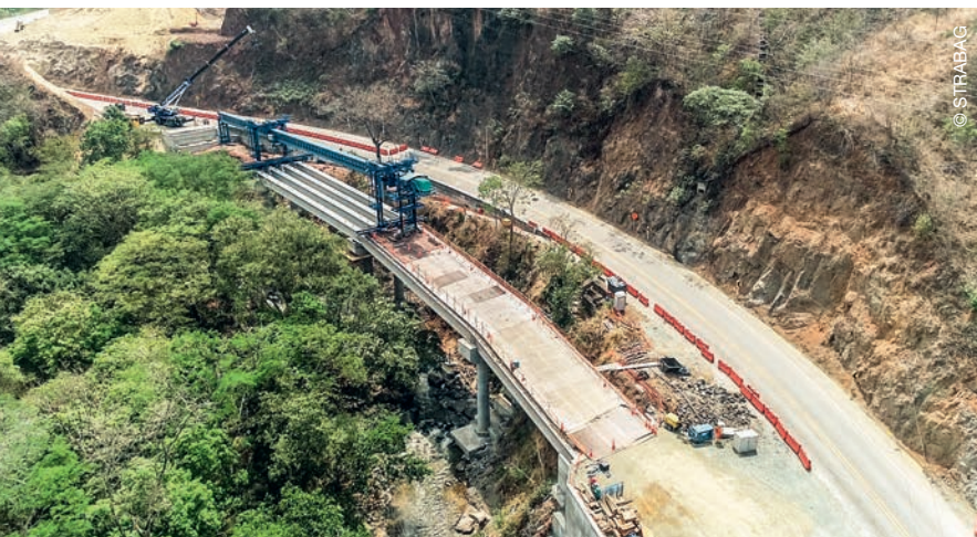
Arbeiten an der Autobahn Autopista al Mar 1 in Kolumbien
