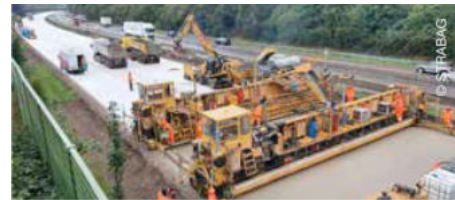
Ausbau der Autobahn A 1
