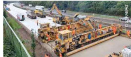
Ausbau der Autobahn A 1
