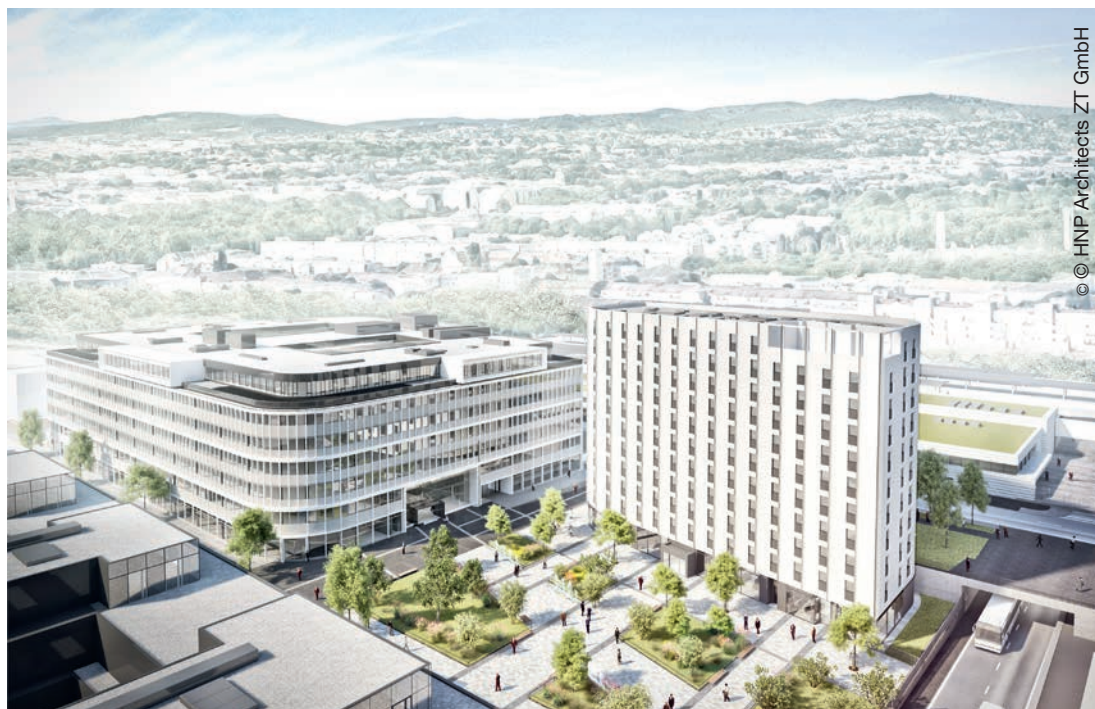
Die von STRABAG Real Estate entwickelten SMARTments in Wien erhielten bereits in der Bauphase das Vorzertifikat der ÖGNI Gold Auszeichnung.
