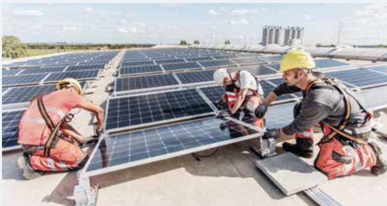
Installation der PV-Anlage auf dem Dach des Mischek-Fertigteilwerks
