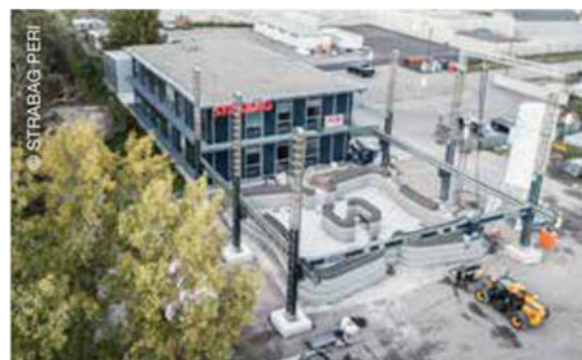
Pioniere im Betondruck
