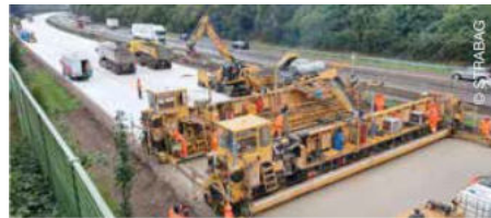
Ausbau der Autobahn A 1
