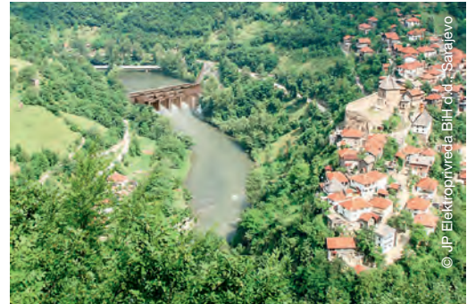
Wasserkraftwerk am Fluss Bosna
