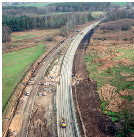
Ausbau der Bahnstrecke Berlin–Dresden
