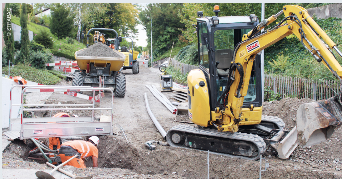
Bauarbeiten in Küsnacht (CH) mit digital abrufbarer, tagesaktueller Anwohnerkommunikation
