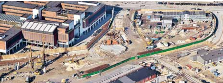
Bau eines 2 km langen U-Bahn-Tunnels
