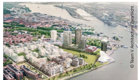
ZÜBLIN errichtet das Großprojekt „Congreshotel & Residential Tower Overhoeks“ in Amsterdam.
