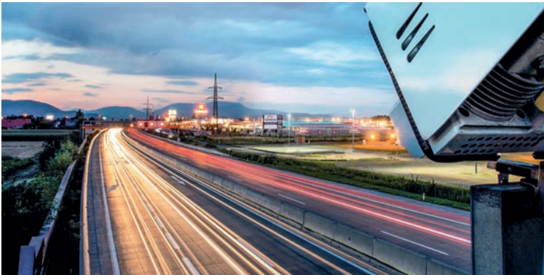
Vollautomatische Kontrollsysteme funktionieren ohne Unterbrechung des Fließverkehrs.
