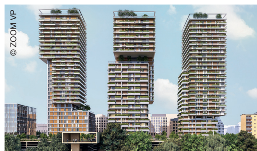
Drei Wohntürme in der Nähe des Wiener Zentrums
