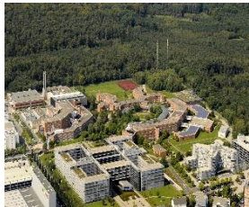
DFS Deutsche Flugsicherung Headquarters Frankfurt, Germany
