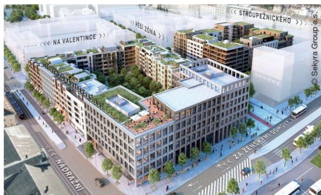
Die erste Bauphase des Stadtentwicklungsprojekts Smíchov City umfasst rd. 400 Wohnungen sowie Büro- und Geschäftsflächen.
