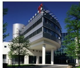
Deutsche Telekom AG, Germany
