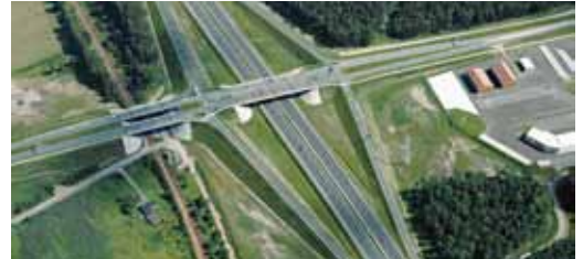
Teilabschnitt der Autobahn A4
