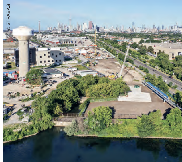
Auf diesem Areal der Ashbridges Bay Wasseraufbereitungsanlage in Toronto wird das Pumpwerk entstehen.
