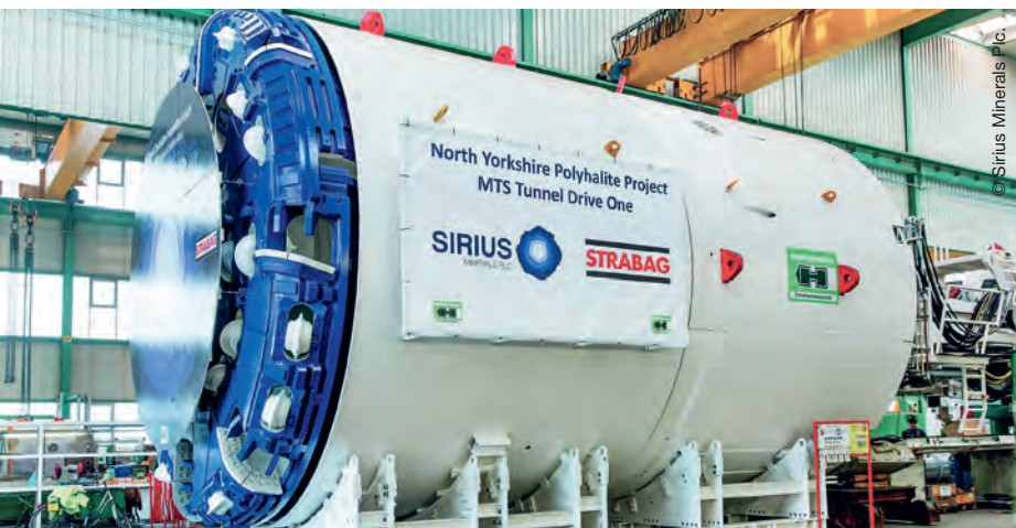
Einsatzbereite Tunnelbohrmaschine Stella Rose in Wilton
