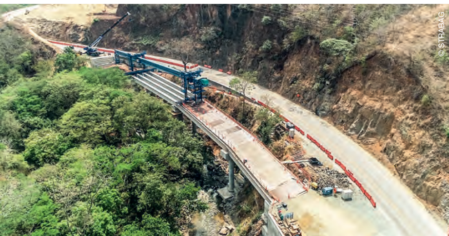
Arbeiten an der Autobahn Autopista al Mar 1 in Kolumbien
