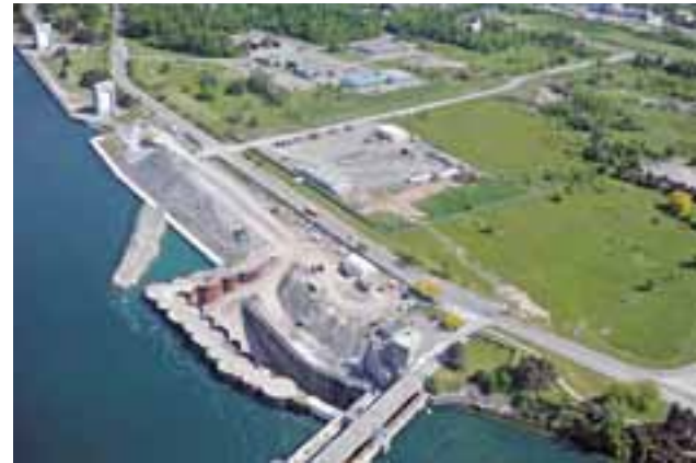
Bau Niagara Tunnel-Projekt
