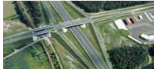
Teilabschnitt der Autobahn A4
