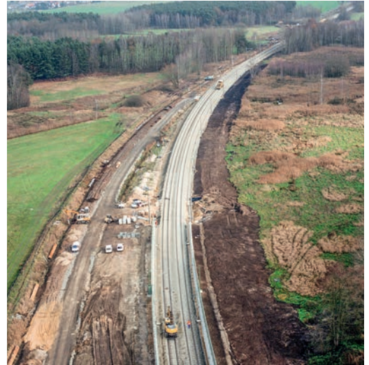
Ausbau der Bahnstrecke Berlin–Dresden
