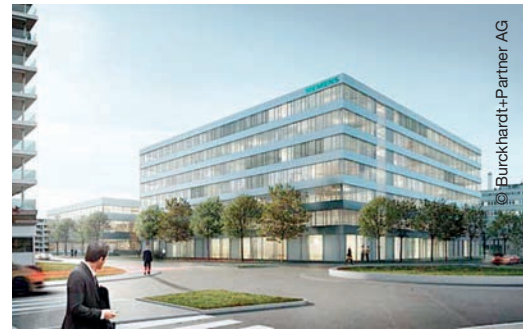
Einsatz von BIM.5D®
