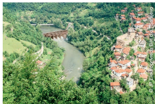
Wasserkraftwerk am Fluss Bosna
