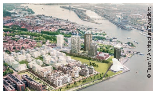
ZÜBLIN errichtet das Großprojekt „Congreshotel & Residential Tower Overhoeks“ in Amsterdam.
