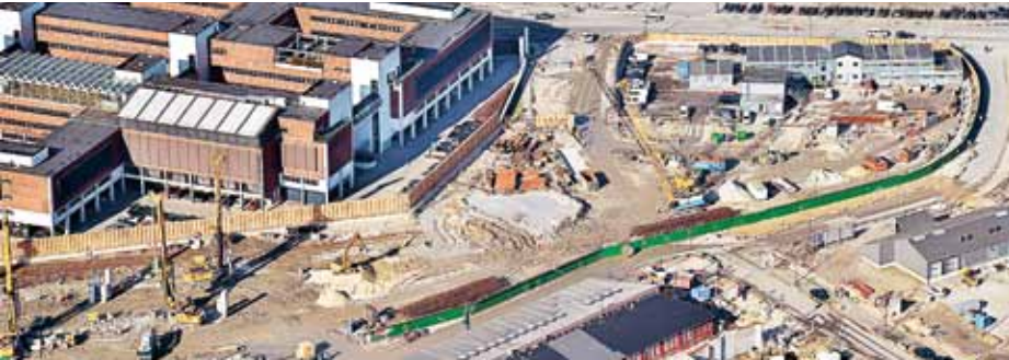
Bau eines 2 km langen U-Bahn-Tunnels
