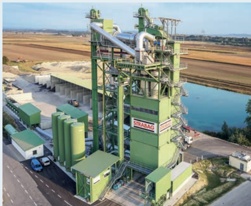
Die Asphaltmischanlage verarbeitet bis zu 50 % Recyclingmaterial.
