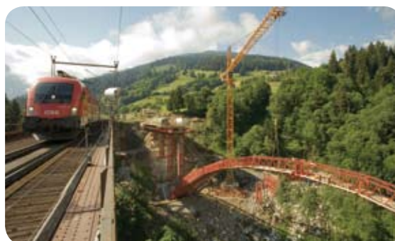
Eisenbahnbrücke Angerschluchtbrücke, Bad Hofgastein, Österreich
