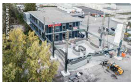
Pioniere im Betondruck
