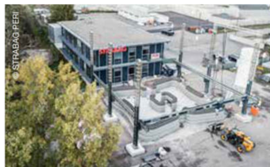
Pioniere im Betondruck
