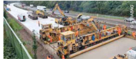
Ausbau der Autobahn A 1
