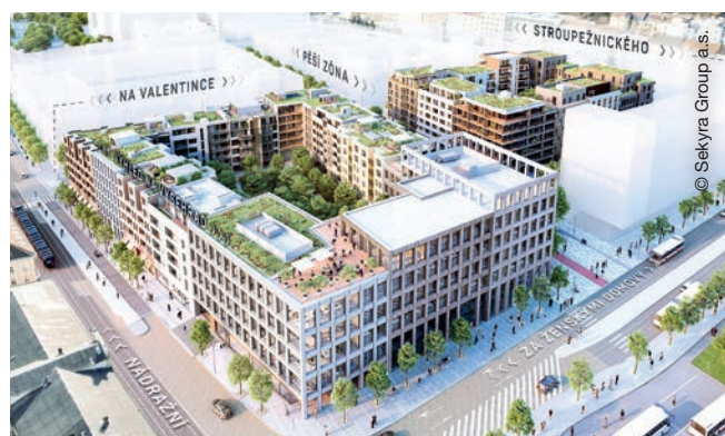
Die erste Bauphase des Stadtentwicklungsprojekts Smíchov City umfasst rd. 400 Wohnungen sowie Büro- und Geschäftsflächen.
