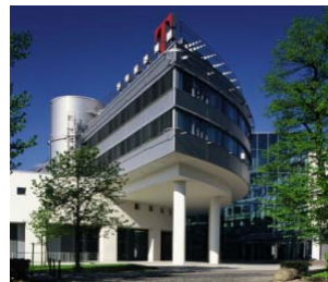
Deutsche Telekom AG, Germany
