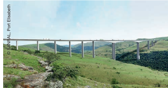
Brücke über den Mtentu-Fluss – nach Fertigstellung die höchste Brücke Afrikas
