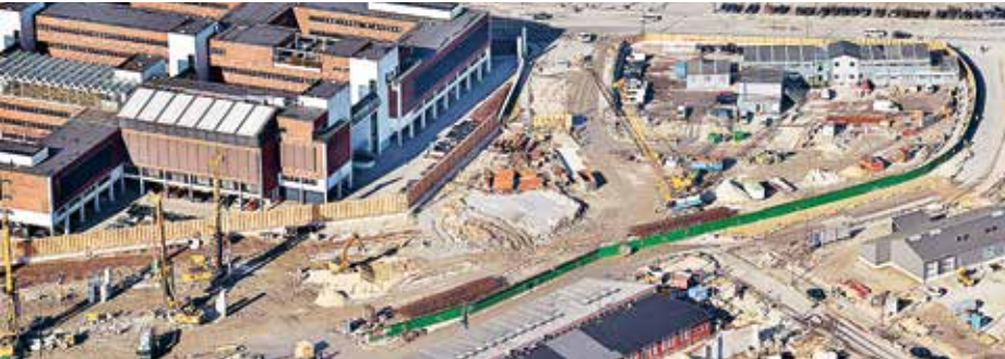
Bau eines 2 km langen U-Bahn-Tunnels
